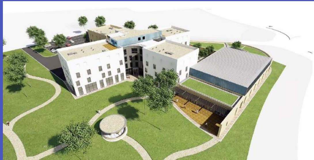
CENTRE DE POSTCURE LES OYATS – Calais (62) Construction d'un centre de postcure psychiatrique
