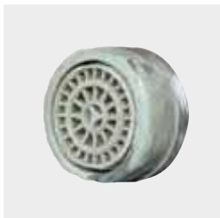
Dépôt de calcaire sur un aérateur
